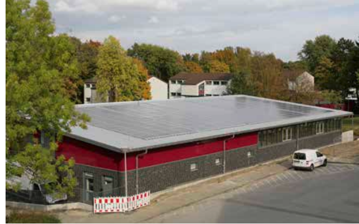
Die Photovoltaikanlage auf dem Dach der Heinz-Sielmann-Schule kann jährlich bis zu 52.000 kWh Strom erzeugen.
