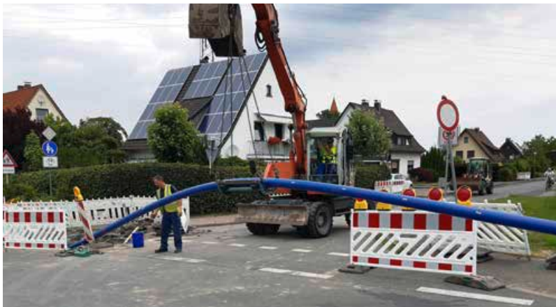
Verlegung neuer Trinkwasserleitungen an der Kreuzung Währentruper Straße / Auf der Brede
