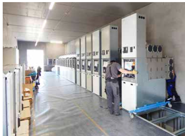
Arbeiten im neuen Umspannwerk An der Bleiche: Einbringung der Felder für die Schaltanlage (oben); Aufstellung der neuen Schaltanlage (unten)
