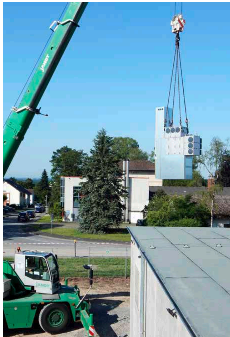
Arbeiten im neuen Umspannwerk An der Bleiche: Einbringung der Felder für die Schaltanlage (oben); Aufstellung der neuen Schaltanlage (unten)
